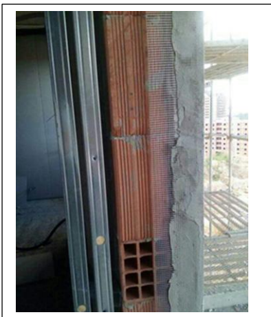
Isolation par Polystyrène
