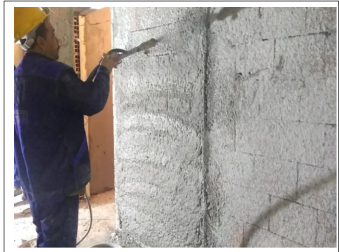
Projection d'enduit sur les murs intérieurs
