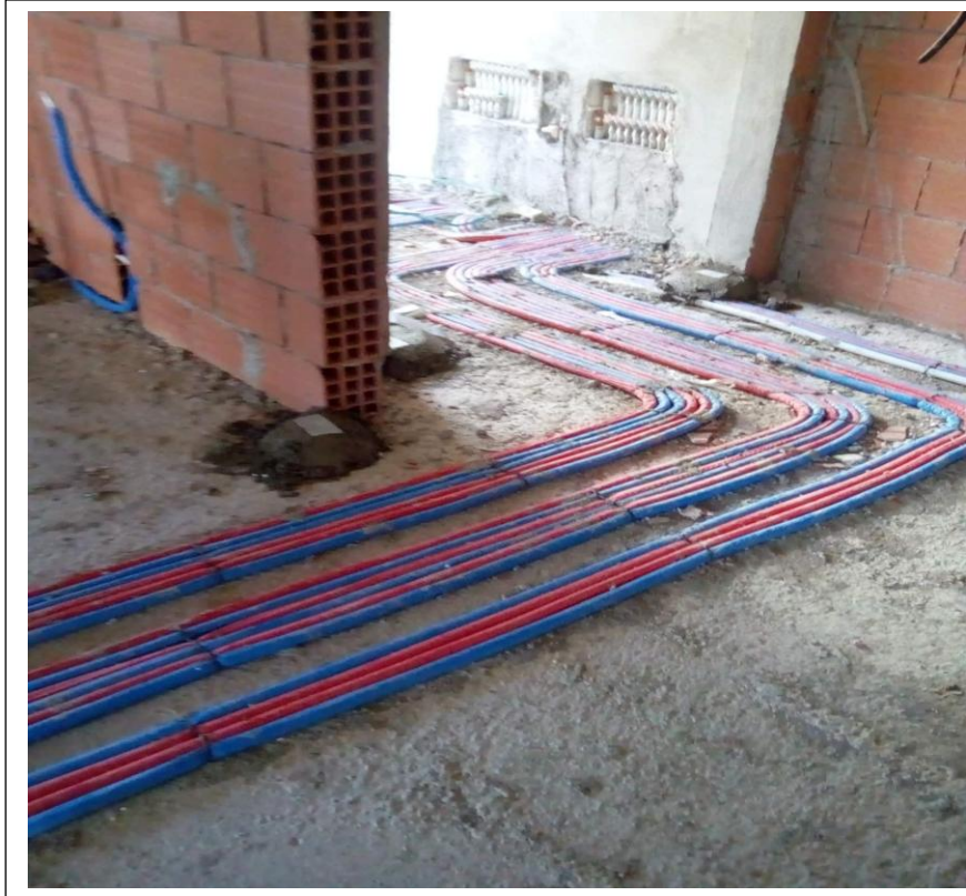
Tuyaux pour chauffage central posés à terre
